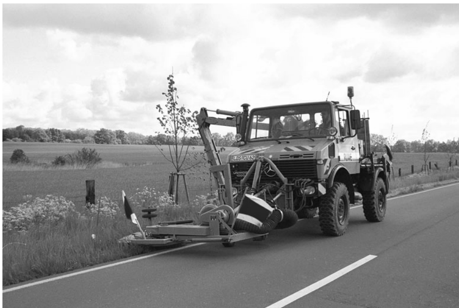
Abb. 12: Schnittmaßnahme am krautigen Straßenbegleitgrün
