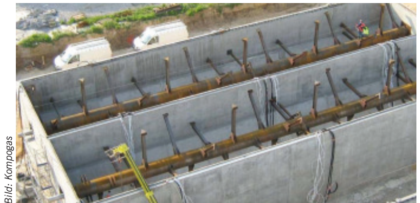
Bild 4: Der im Bau befindliche liegende Pfropfenstromfermenter dient später der thermophilen, kontinuierlichen Trockenfermentation von Bioabfall.
